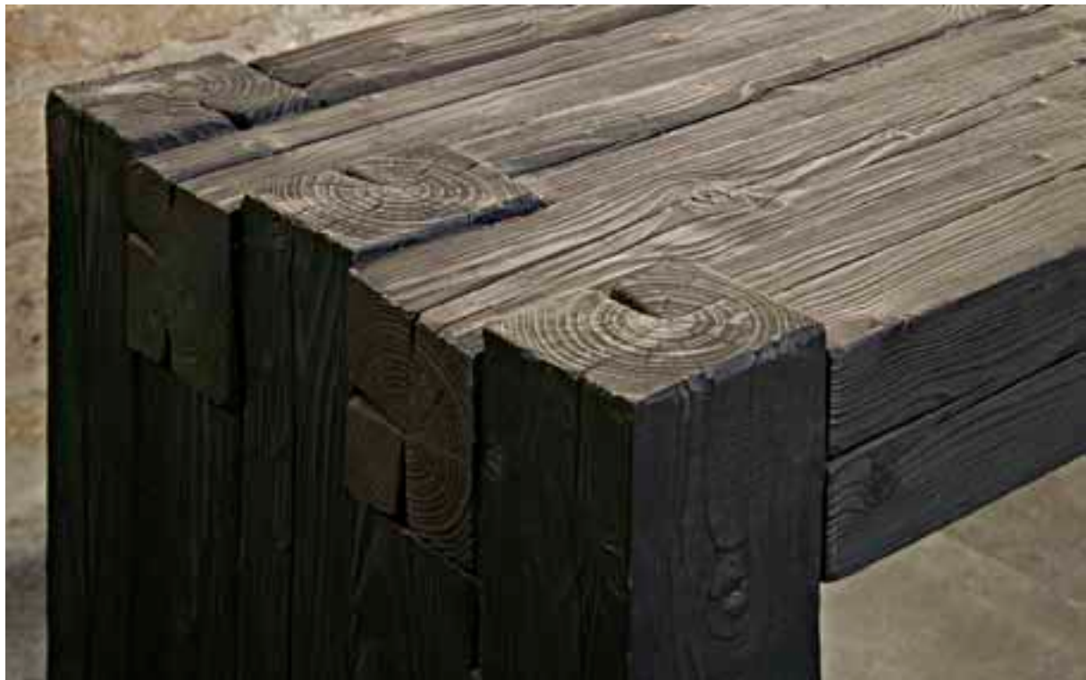
Eckverbindung mit Fingerzinken
